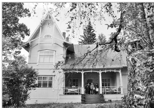
В настоящее время дача «Чайка» – филиал областной картинной галереи. В 2013 году в здании проведен капитальный ремонт, здесь проходят выставки и музейные мероприятия
